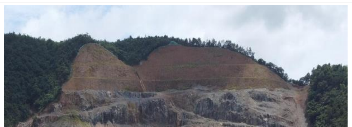
南侧上部已治理边坡现状
