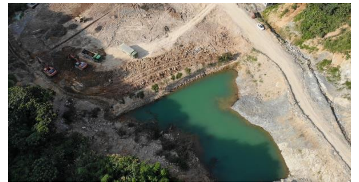
治理区北东侧、北侧两处主要蓄水沉淀池（可利用）
