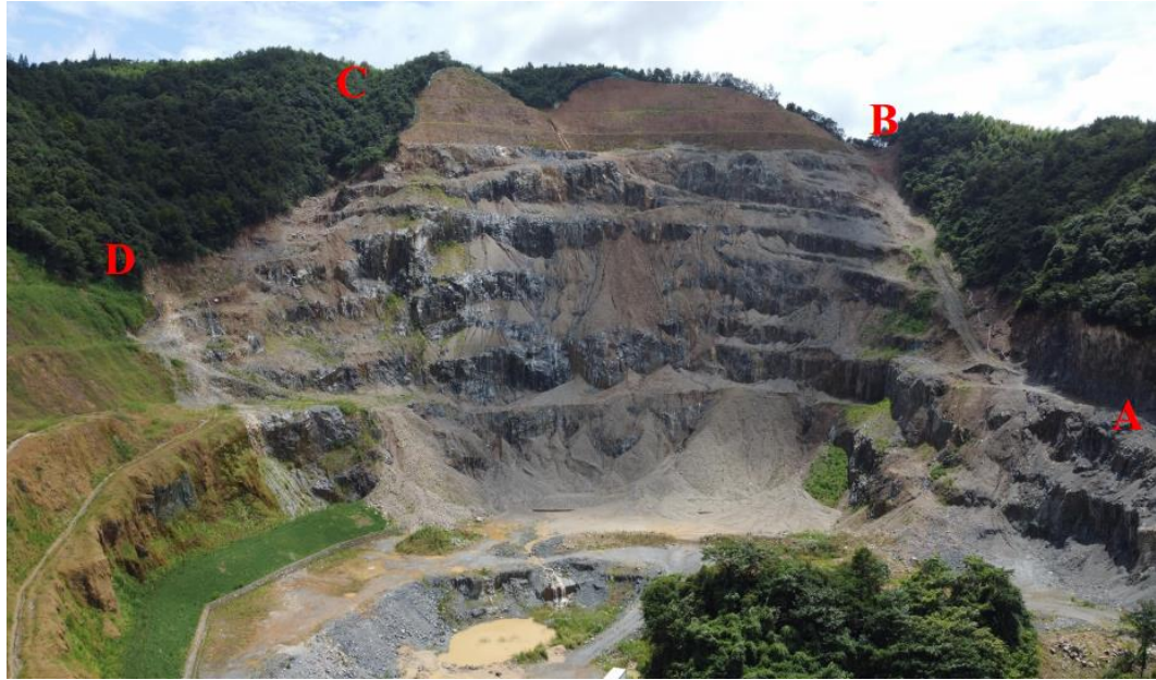
图2-1 废弃矿山边坡现状图
