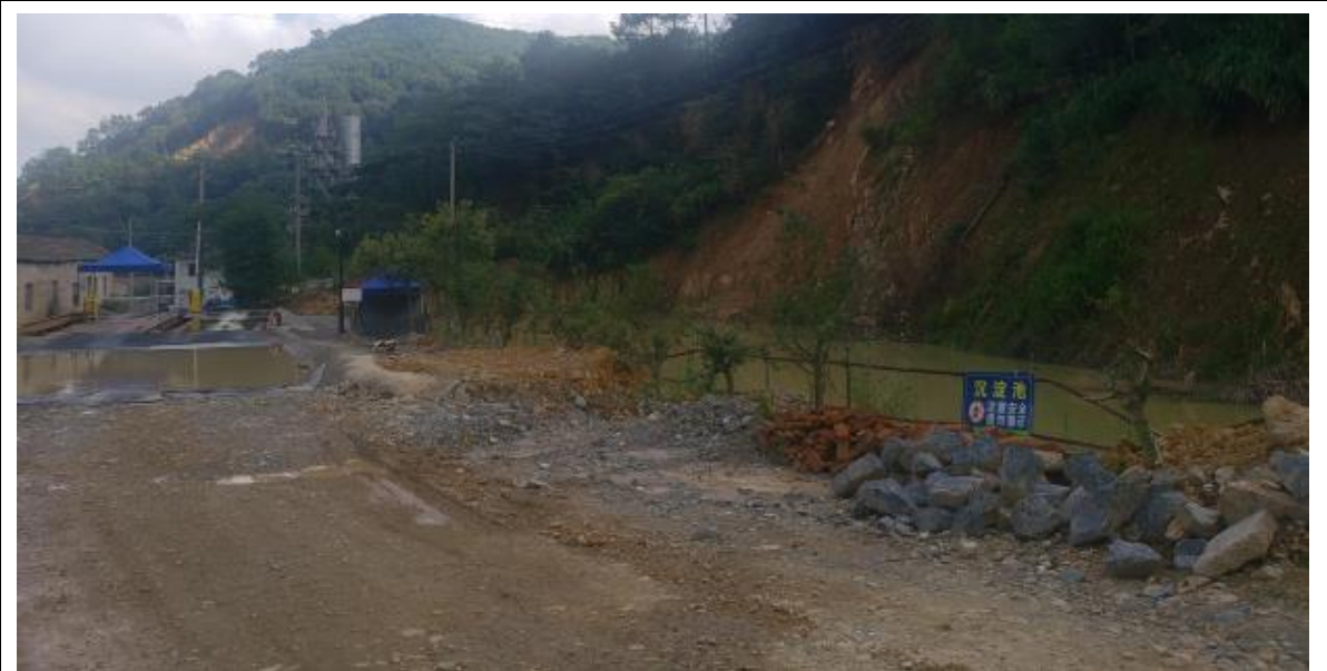
治理区北东侧蓄水沉淀池及车轮冲洗池（可利用）
